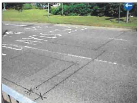
Figura 21 – Exemple de bucle inductive de detecție a vehiculelor (și opțional măsurarea exactă a vitezelor de deplasare)
