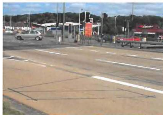
Figura 21 – Exemple de bucle inductive de detecție a vehiculelor (și opțional măsurarea exactă a vitezelor de deplasare)
